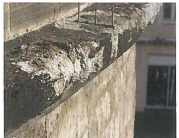
Verwitterungsschäden am Gesims
