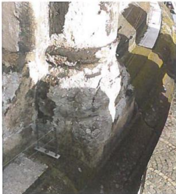
Starke Schalenbildung an der Basis
