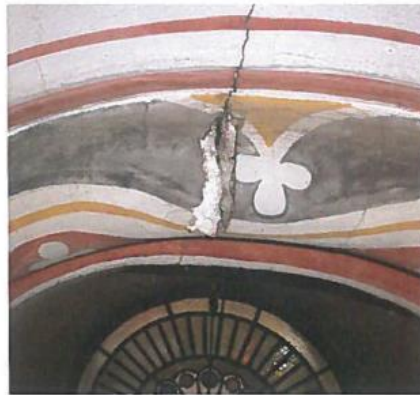
Riss im Bogenscheitel
