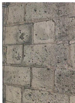
Fehlerhafte Verfungung
