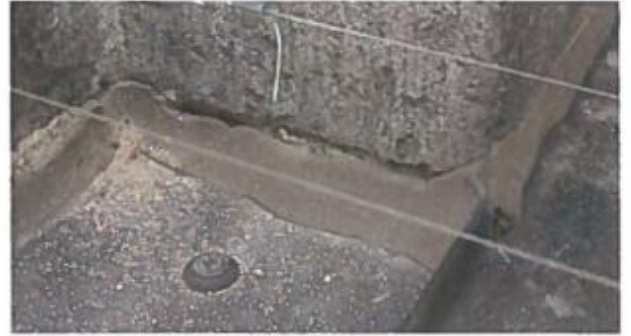
Fehlerhafte Verfugung
