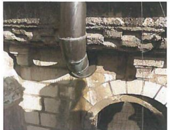
Fehlerhafte Wasserableitung
