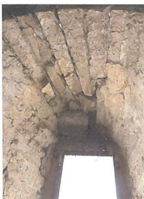
Riss durch gesamten Wandquerschnitt
