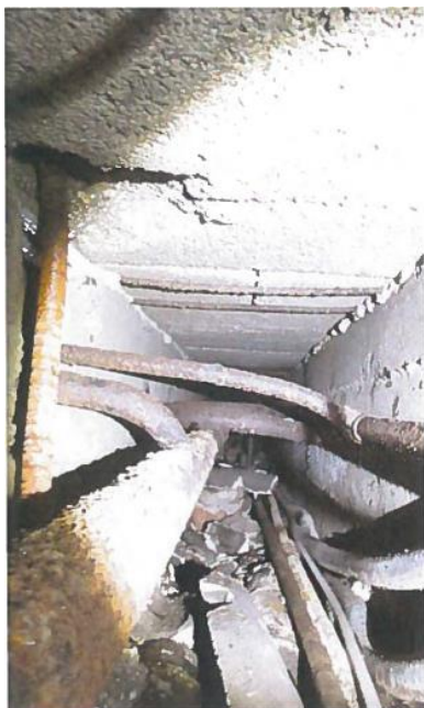
Vorhandener Installationsschacht Seitenschiff
