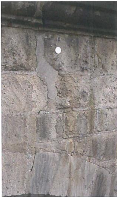
Defekte mineralische Ausbesserung
