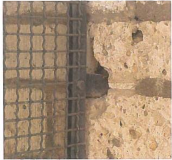
Ausbruch der Verankerung des Fenstergitters
