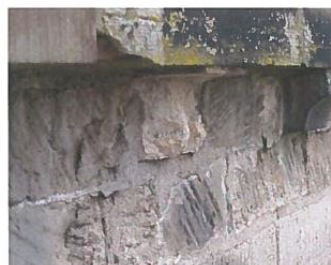
Rückwitterung durch Riss im Gesims
