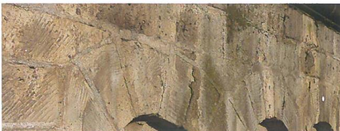
Rückwitterung durch falsche Wasserableitung
