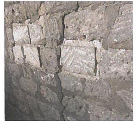
Riss in der Wandfläche
