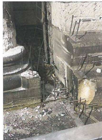
Rostsprengung durch Taubenvergrämung
