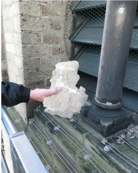
Abgeplatzte Mörtelausbesserung
