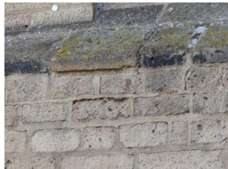
Steinfraß aufgrund zu harter Mörtelfugen
