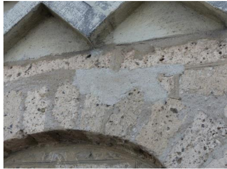
Ausbesserung mit zu hartem Mörtel
