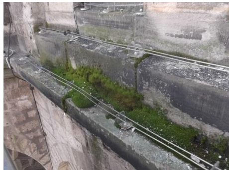
Ausbesserung mit zu hartem Mörtel
