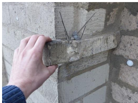
Abplatzung durch Taubenschutzbefestigung
