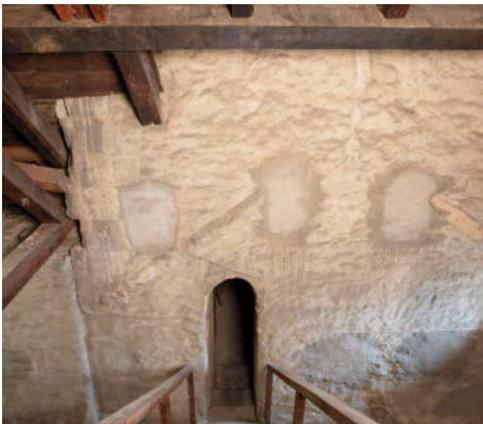
20. Bonner Münster, Dachraum über der Chorapsis, Blick auf den nördlichen Chorflankenturm mit Dachanschlag des ursprünglichen Querdachs, 2019.
