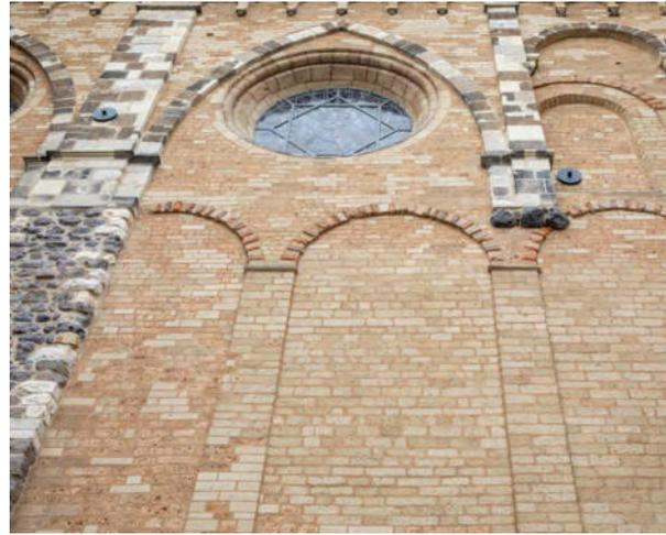
11. Bonner Münster, Langchor, Südseite, Blick auf Blendbögen und gestaffelte Fassadengliederung, mittelalterliches Mauerwerk aus hellbraun-rötlichem Römertuff und ausgewechselte Flächen aus hellerem Weiberner oder Etringer Tuff, 2024.
