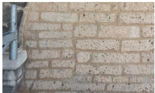
23. Bonner Münster, mittelalterliches Mauerwerk aus Römertuff mit Fugung des 19. Jahrhunderts in hellbraunem Kalkmörtel mit einfacher oder doppelter Fugenritzung (Nordseite des Langchors, Bereich links oben unter dem doppelten Blendbogen), 2019.
