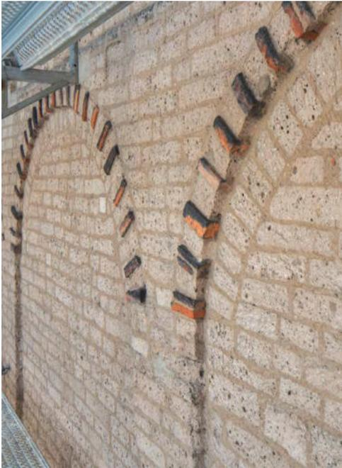
12. Bonner Münster, Langchor, Nordseite, salische Blindbögen mit Wechsel von Römertuff und römischen Ziegeln in der Bogenmauerung.
